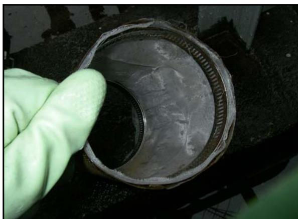
資料写真1-1 Yストへの平網仮設状況
